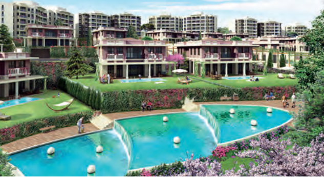
Söğüt Bahçe Konutları 7 blok ve 342 daireden oluşuyor.
